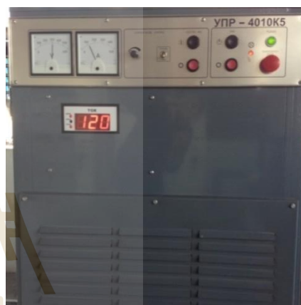
ฉ. ระบบจ่ายกำลังไฟฟ้า
