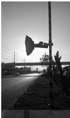
รูปที่ 3.5 การติดตั้งอุปกรณ์
