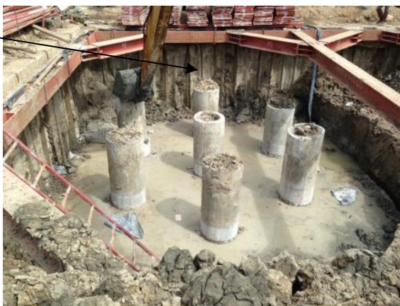
รูปที่ 2.3 งานขุดดิน โดยใช้ระบบกำแพงกันดินแบบเสาเข็มตอกเรียงต่อเนื่อง
