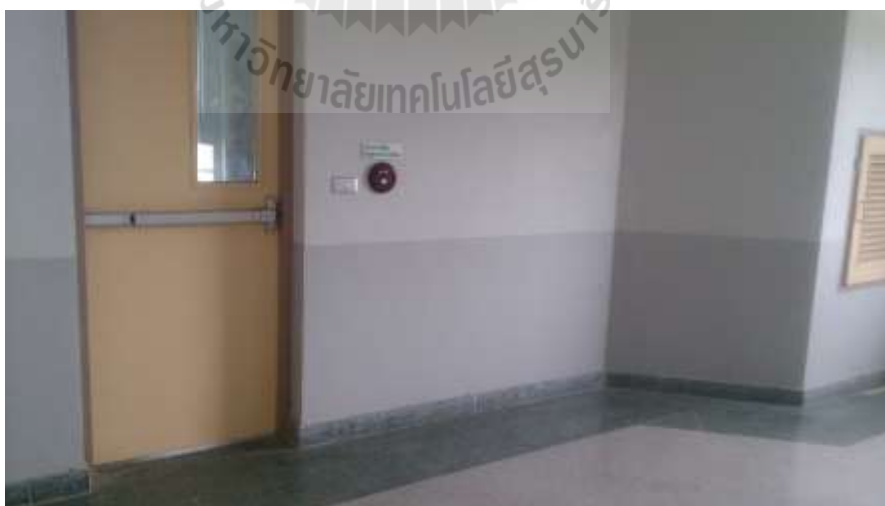
รูปที่ 4.8 (1) พื้นที่ชั้น 3 บริเวณพื้นที่เดียวกับรอยร้าวผนังในชั้นลอย
