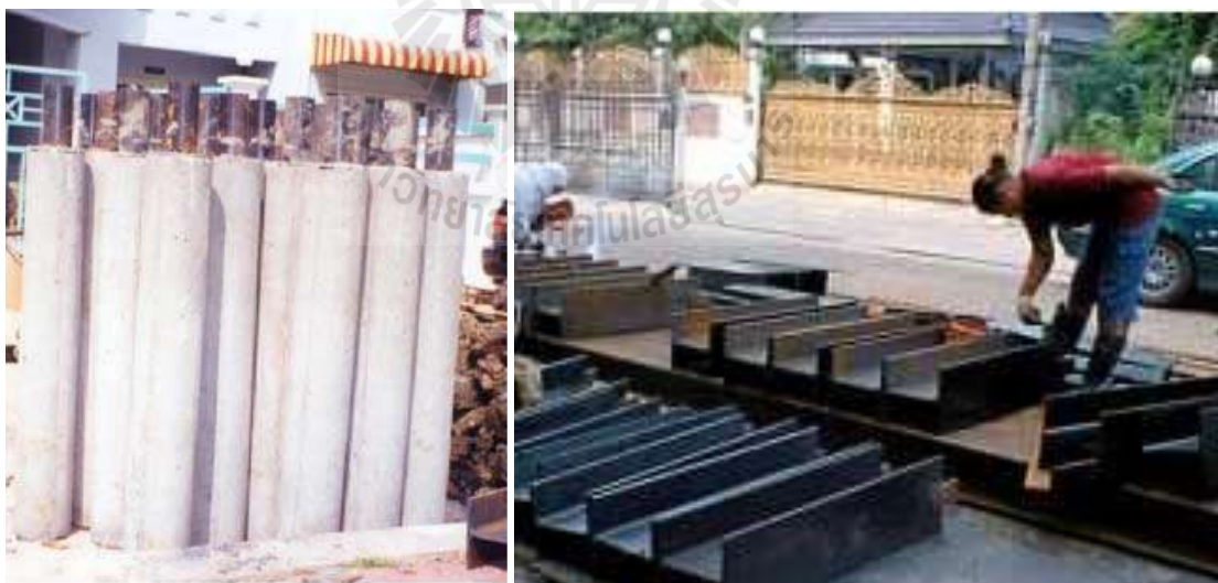
รูปที่ 2.23 เสาเข็ม FM-Pile และเสาเข็มเหล็ก H-Beam
