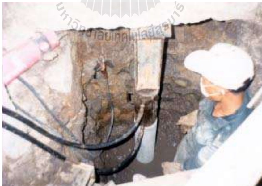
รูปที่ 2.25 การกดเสาเข็มลงดิน (คุณชนศ วีระศิริ บริษัท ฟิเนสต์ ซอยล์ เทสติ้ง จำกัด, ปี พ.ศ. 2544)
