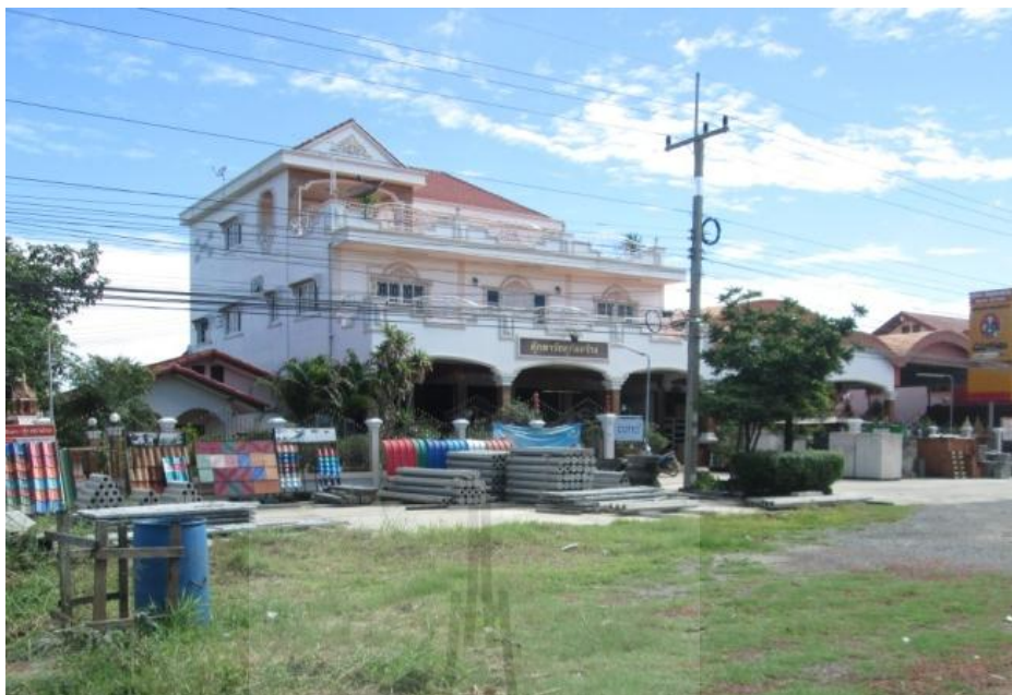
รูปที่ 3.4 การวางวัสดุก่อสร้างรुक้าเขตทางหลวง
