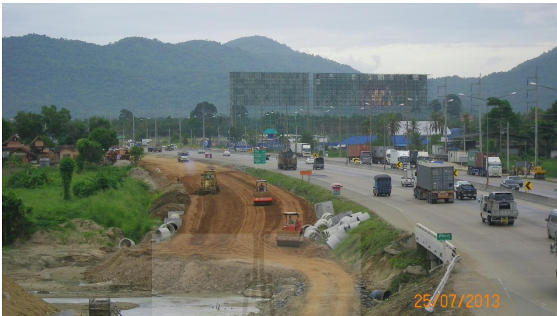
รูปที่ ค.3 สภาพการก่อสร้างในสนามด้านซ้ายทาง
