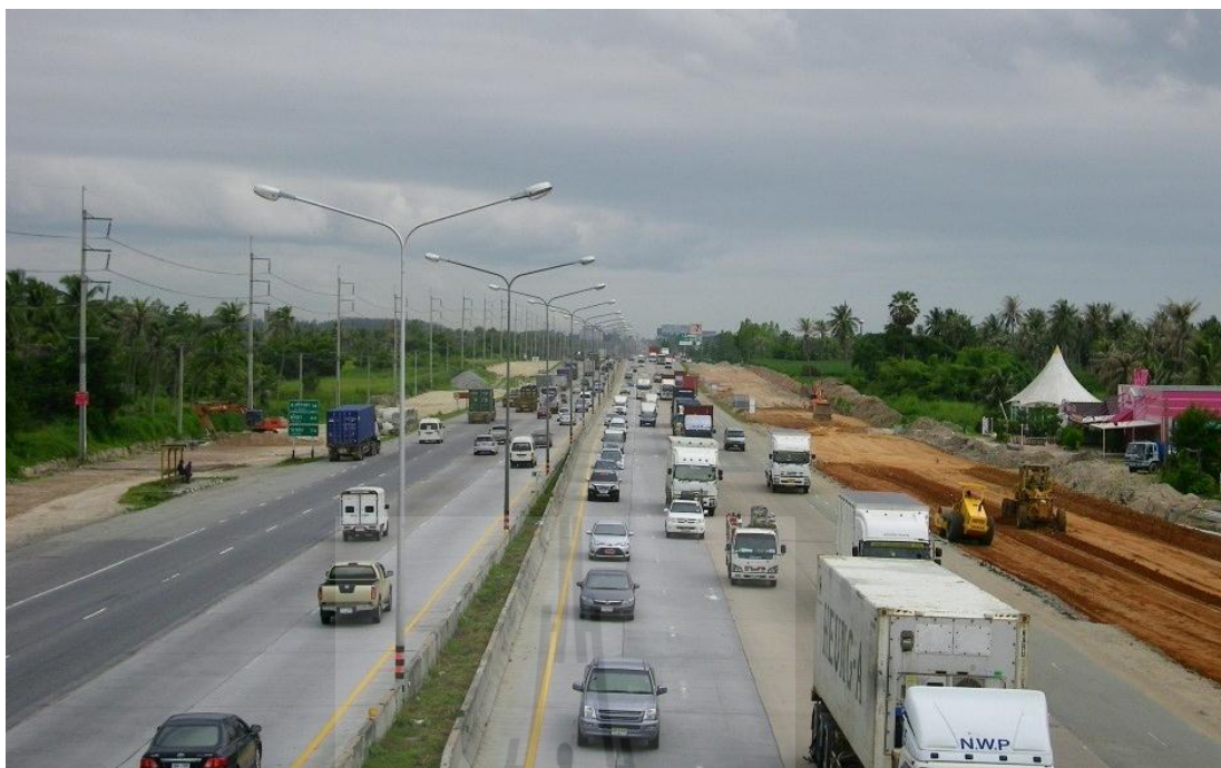
รูปที่ 1.4 สภาพพื้นที่การก่อสร้างในสนามเดือนสิงหาคม 2556
