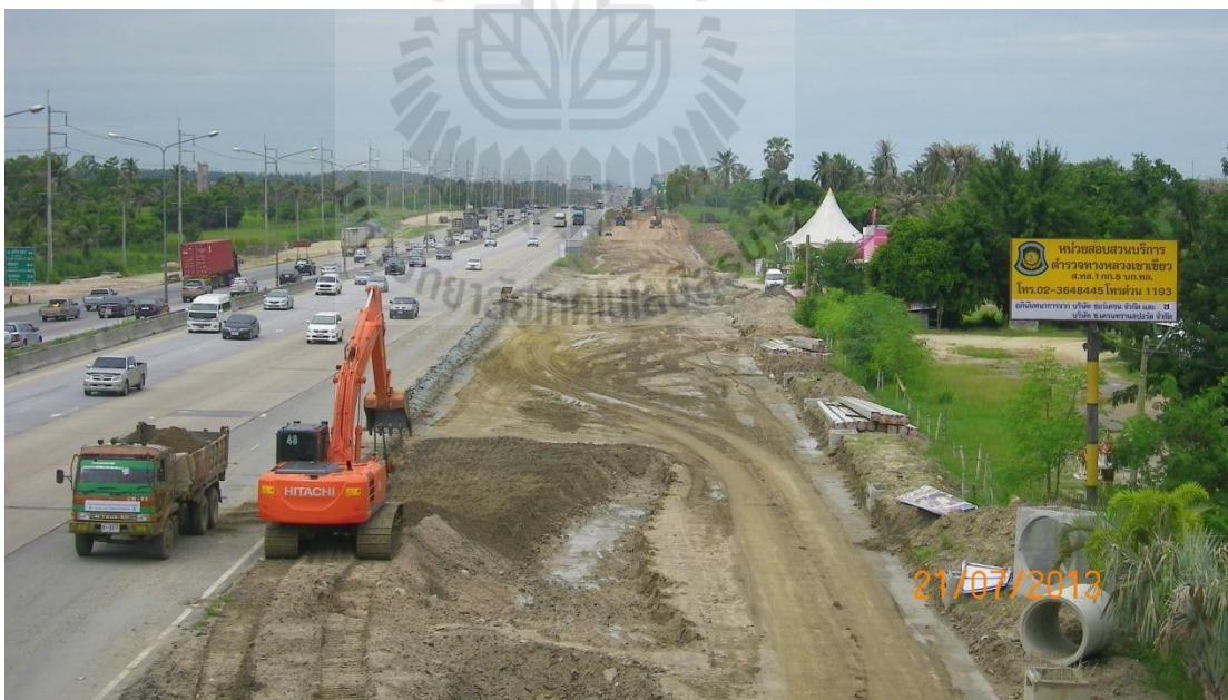
รูปที่ ค.4 สภาพการก่อสร้างในสนามด้านขวาทาง
