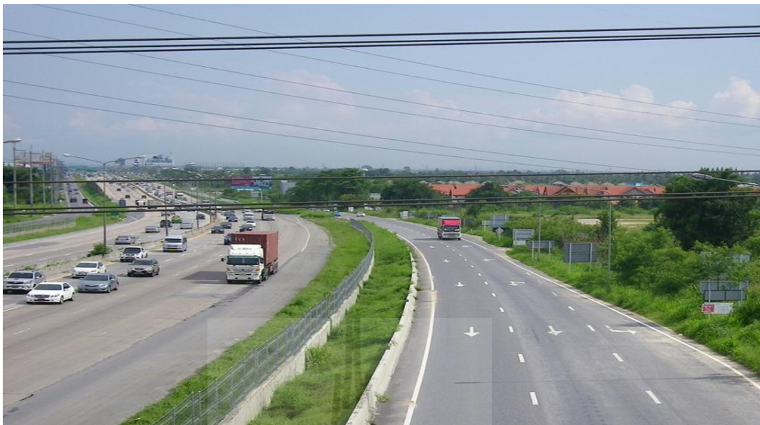
รูปที่ ค.5 ทางบริการเดิมบางช่วงที่ต้องปรับปรุงใหม่
