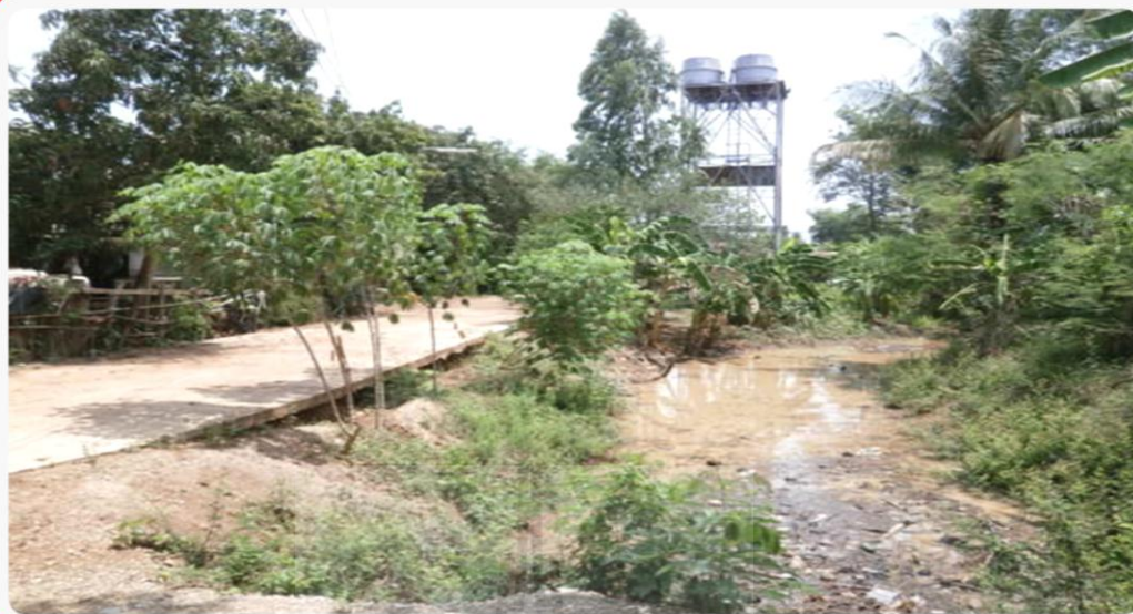
รูปที่ 4.1 สภาพพื้นที่สถานที่ตั้งระบบประปาหมู่บ้าน หมู่ที่ 1 บ้านหันทราย สภาพพื้นที่ : อยู่ติดชุมชนขนาดใหญ่ ดินล้ารางระบายน้ำ ขยะและเศษวัชพืช
