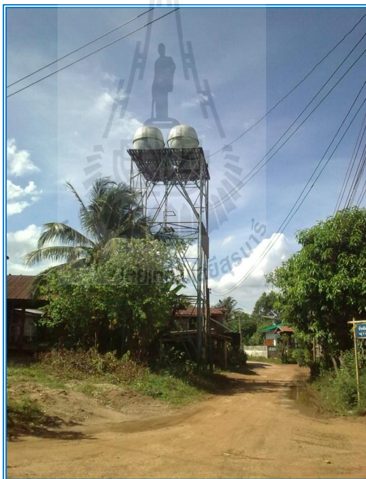
รูปที่ 2.7 ระบบประปาหมู่บ้าน หมู่ที่ 5 บ้านหันทราย (จุดที่ 1)
