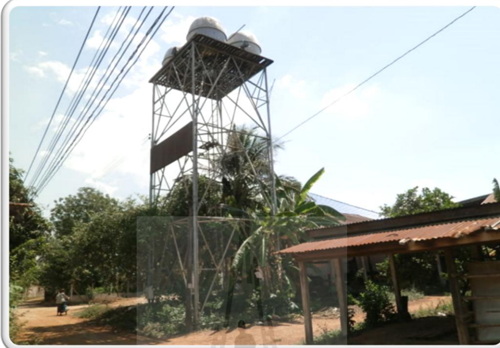
รูปที่ 4.5 สภาพพื้นที่สถานที่ตั้งระบบประปาหมู่บ้าน หมู่ที่ 5 บ้านหันทราย (จุดที่ 1)
