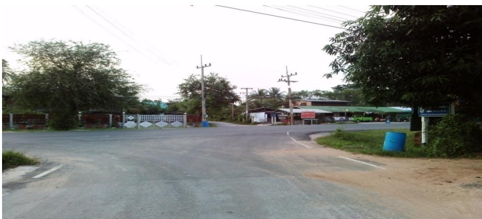
รูปที่ 4.6 จุดเสี่ยงบริเวณทางแยก บ้านหนองปรือ หมู่ที่ 14
