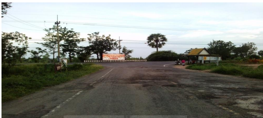
รูปที่ 4.1 จุดเสี่ยงบริเวณแยกทางเข้าบ้านหนองขาม หมู่ที่ 7
