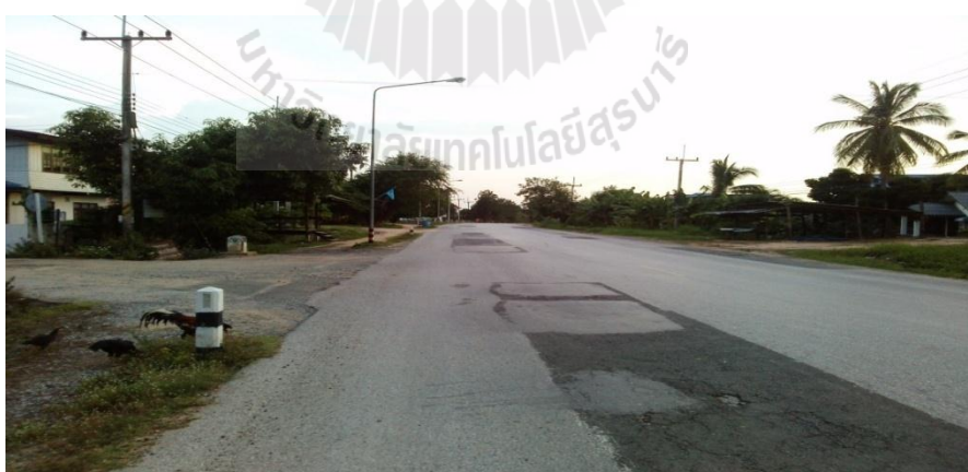
รูปที่ 4.4 จุดเสี่ยงบริเวณทางโค้งบ้านหนองปรือ หมู่ที่ 4
