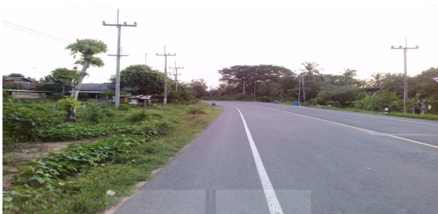
รูปที่ 4.3 จุดเสี่ยงบริเวณทางโค้งบ้านบุสามัคคี หมู่ที่ 9
