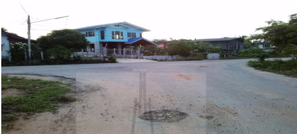
รูปที่ 4.5 จุดเสี่ยงบริเวณทางแยกภายในหมู่บ้าน บ้านหนองปรือ หมู่ที่ 4
