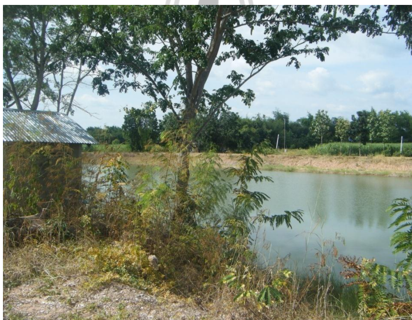
รูปที่ 1.2 ระบบประปา บ้านสามสวนเหนือ หมู่ที่ 4 ใช้ร่วมกับ บ้านป่าเลี้ยวหมู่ที่ 16 แหล่งน้ำดิบมีปริมาณไม่เพียงพอ ขาดแคลนในฤดูแล้ง
