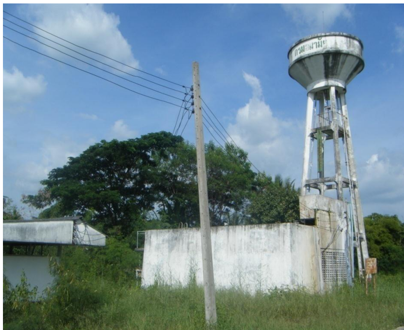
รูปที่ 1.5 ระบบประปา บ้านสามสวนกลาง หมู่ที่ 14 มีสภาพเก่าทรุดโทรม เนื่องจากใช้งานมานาน
