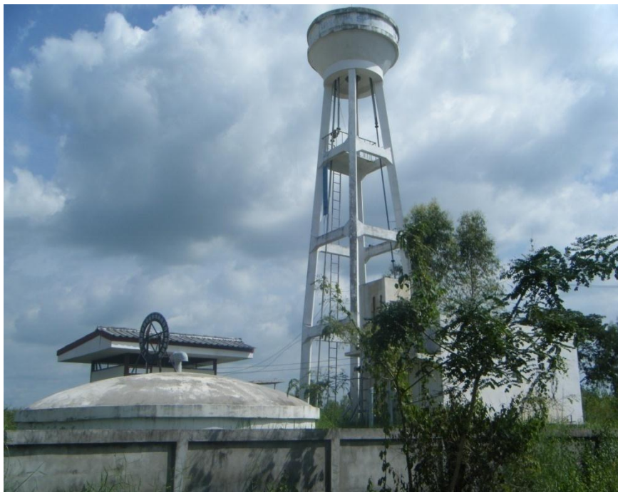
รูปที่ 1.3 ระบบประปา บ้านสามสวนใต้ หมู่ที่ 9 ใช้ร่วมกับ บ้านสระแก้ว หมู่ที่ 15 และ บ้านสามสวนโพธิ์งาม หมู่ที่ 17 ระบบผลิตน้ำประปามีขนาดเล็กเกินไป
