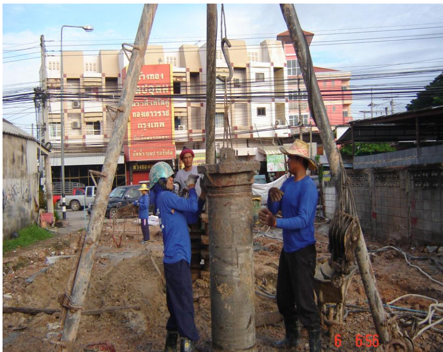
รูปที่ 2.31 PUT CASING IN TO STABLE CLAY การต่อปลอกเหล็ก (Casing)
