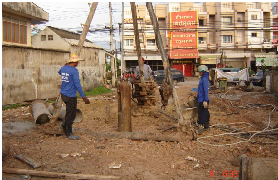
รูปที่ 2.29 จัดเครื่องมือเข้าสู่ศูนย์เสาเข็มเจาะ
