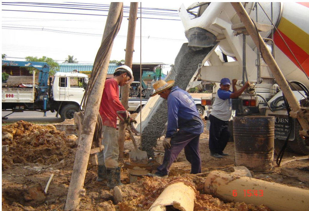
รูปที่ 2.34 FILL WITH CONCRETE การเทคอนกรีตลงในรูเจาะ
