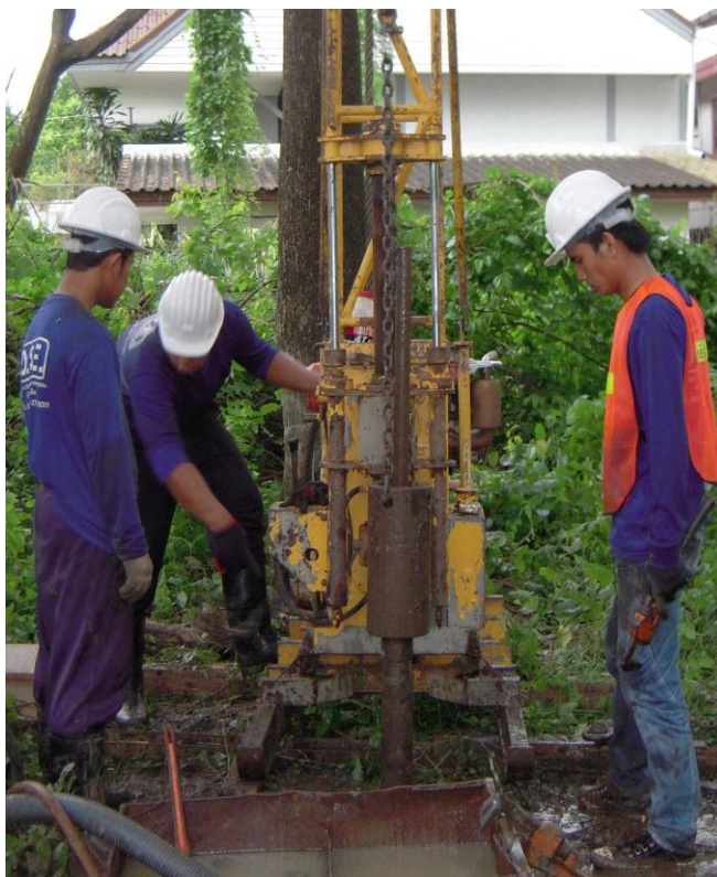
รูปที่ 2.11 ภาพถ่ายการเจาะแบบเปียก (Wash boring)
