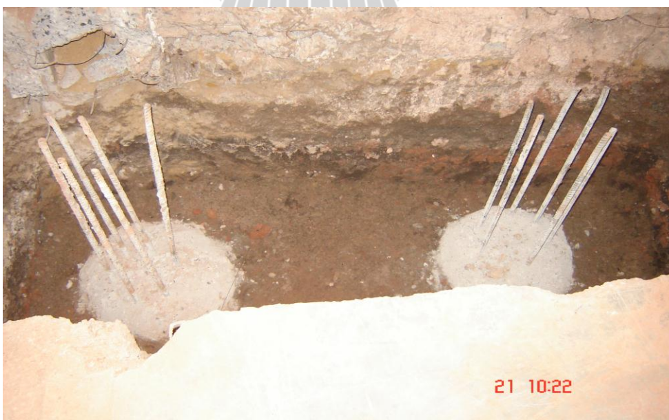
รูปที่ 2.36 COMPLETED PILE เมื่อคอนกรีตได้อายุแล้ว ต้องสกัดหัวเสาเข็มเจาะให้เรียบ และสูงกว่าระดับใต้ฐานราก ประมาณ 5-7 ซม.
