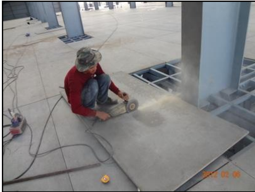
รูปที่ 4.16 การตัดเศษแผ่น VIVA เพื่อเสริมช่องข้างเสา
