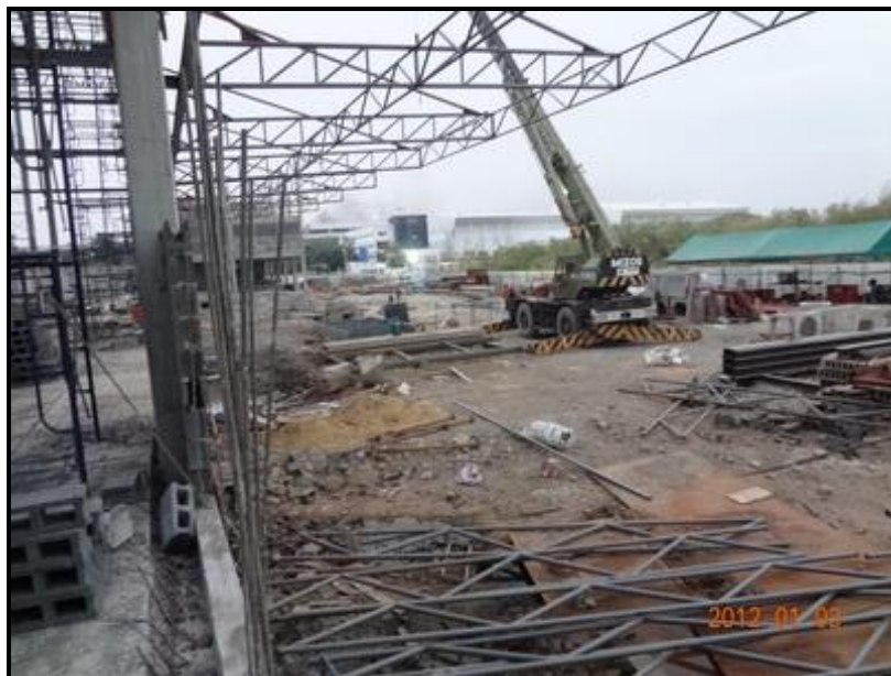
รูปที่ 4.15 การกองเก็บเหล็กรูปพรรณที่ไม่เรียบเกิดความเสียหายต่อชิ้นงานภายหลัง
