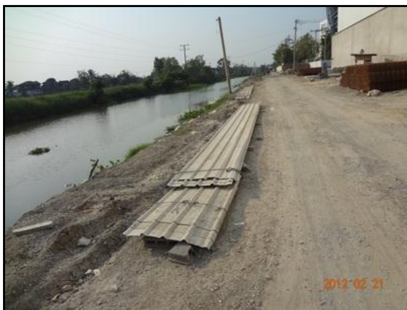
รูปที่ 4.18 การกองเก็บแผ่นผนังที่ไม่เรียบร้อย
