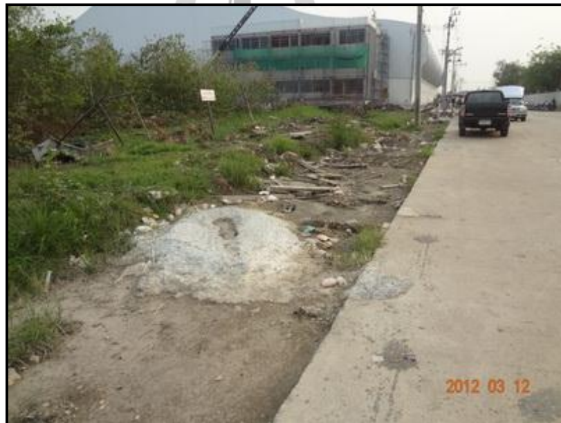
รูปที่ 4.6 คอนกรีตที่เหลือจากการเทแต่ละครั้ง
