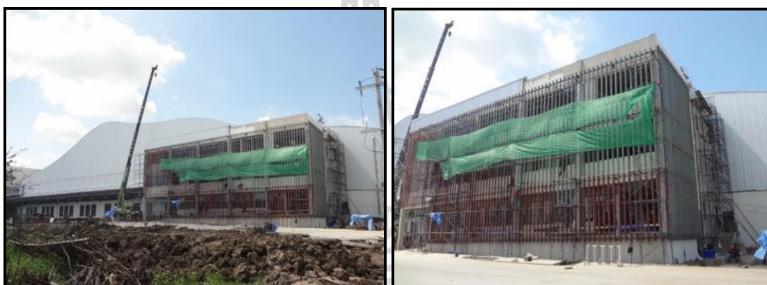
รูปที่ 4.2 โครงการปรับปรุงอาคารคลังสินค้า เอส.บี.บางบัวทอง (ที่แล้วเสร็จ 97 %)
