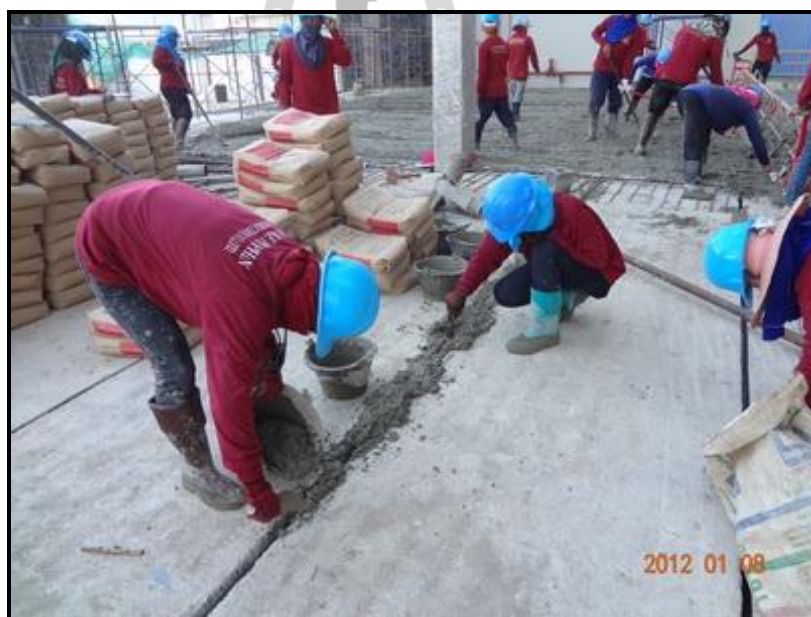
รูปที่ 4.8 การเทคอนกรีตอุดร่องระหว่างรอยต่อพื้น HC
