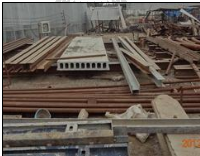
รูปที่ 4.11 การกองเก็บแผ่นพื้นที่เสี่ยงต่อการเกิดความเสียหาย
