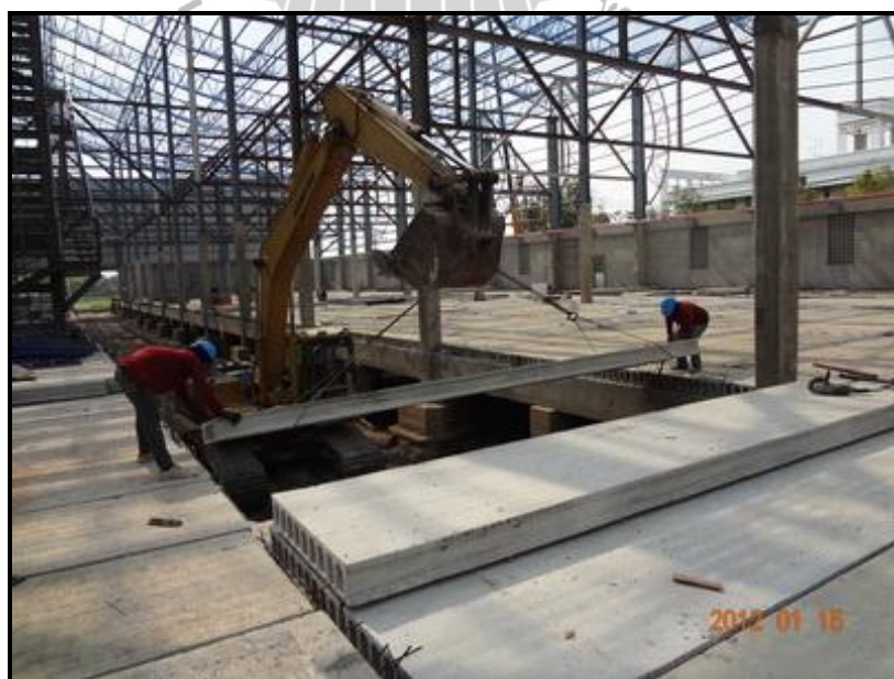
รูปที่ 4.13 การวางแผ่นพื้นสำเร็จโดยใช้รถแบ็คโฮ
