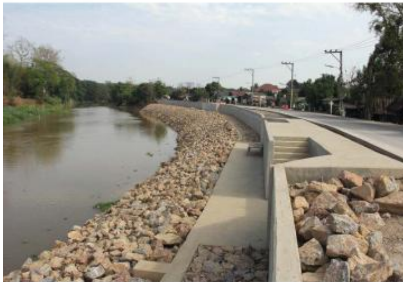
รูปที่ 2.10 ดาดคอนกรีตพร้อมเรียงหินใหญ่แม่น้ำชี
