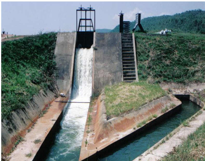
รูปที่ 2.14 ดาดคอนกรีตในคลองส่งน้ำ
