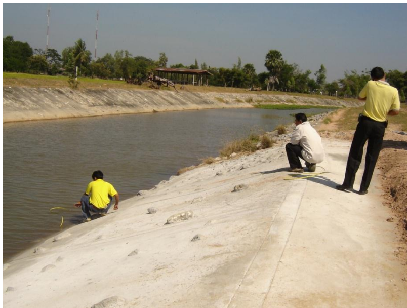
รูปที่ 2.12 ดาดคอนกรีตพร้อมเรียงหินใหญ่ลำนน้ำชีสาขา
