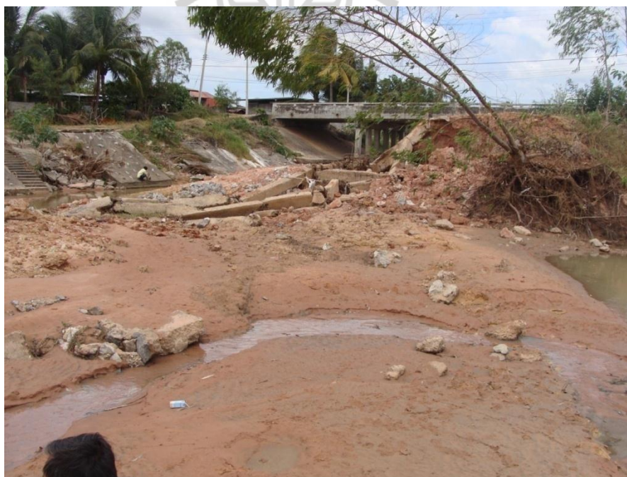
รูปที่ 2.18 ลักษณะการกัดเซาะตลิ่งจุดที่เป็น โถ่งน้ำของคาคอนกรีตพร้อมเรียงหินใหญ่เดิม
