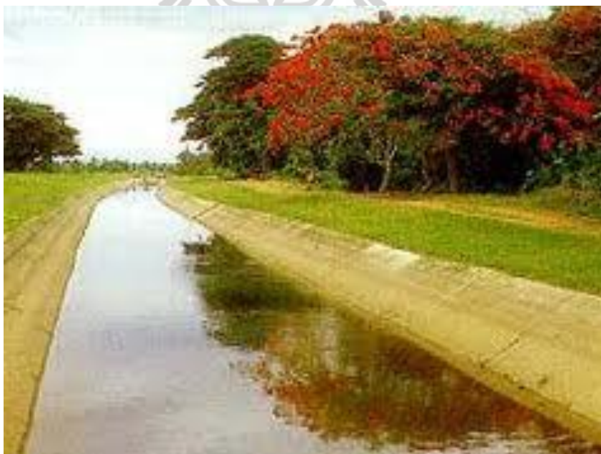
รูปที่ 2.13 ดาดคอนกรีตในคลองส่งน้ำ
