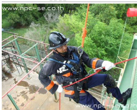
รูปที่ 2.4 การป้องกันความปลอดภัยในการทำงานในที่สูง
