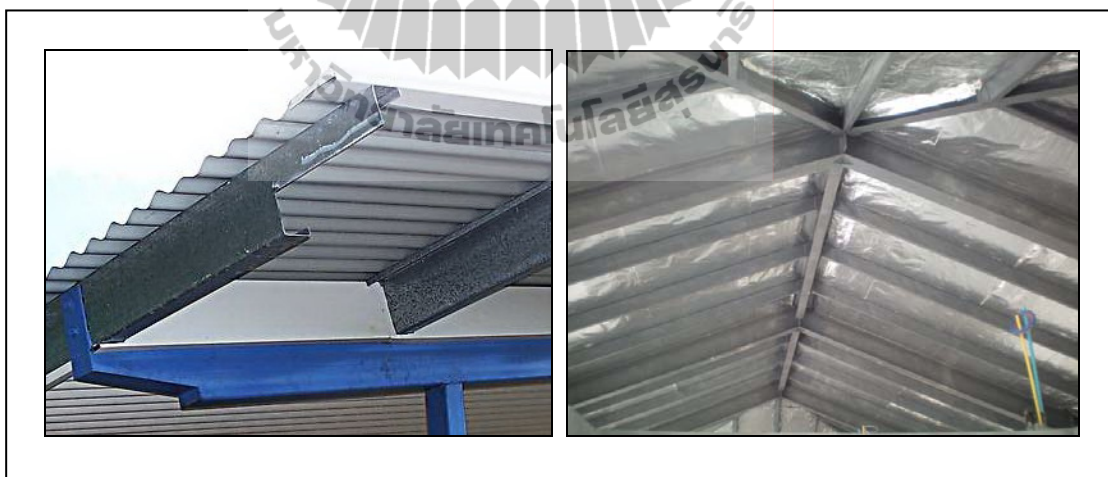
รูปที่ 1.2 โครงสร้างแปและชิ้นส่วนโครงสร้างที่ใช้เหล็กรูปพรรณหน้าตัดรูปรางน้ำ
