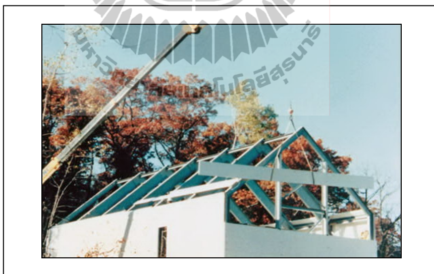
รูปที่ 2.4 การติดตั้งโครงข้อแข็งที่ทำจากวัสดุ FRP ระหว่างการก่อสร้าง (Strongwell, 2002)
