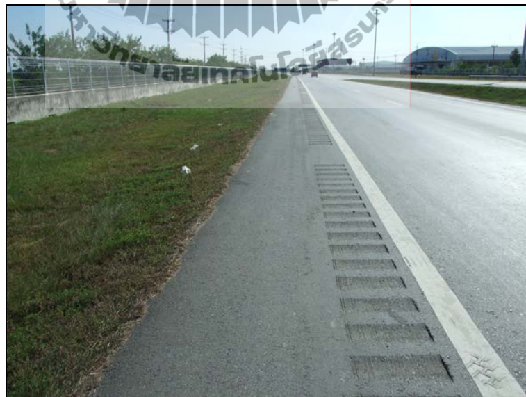
รูปที่ 3.11 ลักษณะ Milled in Shoulder Rumble Strips หลังติดตั้งแล้วเสร็จ
