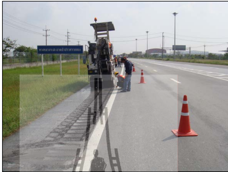
รูปที่ 3.10 การติดตั้ง Milled in Shoulder Rumble Strips
