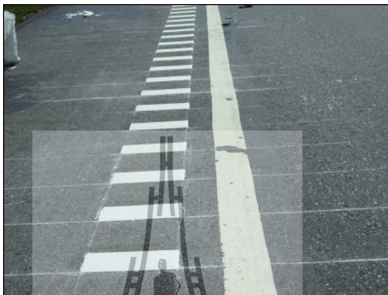
รูปที่ 3.8 ลักษณะ Transverse Raised Shoulder Rumble Strips หลังติดตั้งแล้วเสร็จ ที่มา : กรมทางหลวง, 2553.
