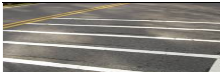
รูปที่ 2.1 ตัวอย่าง Rumble Strips แบบนูน
