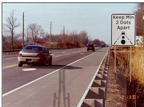
รูปที่ 2.5 ตัวอย่างการใช้เครื่องหมายจราจรบนพื้นทางและป้ายบังคับของ Pennsylvania DOT
