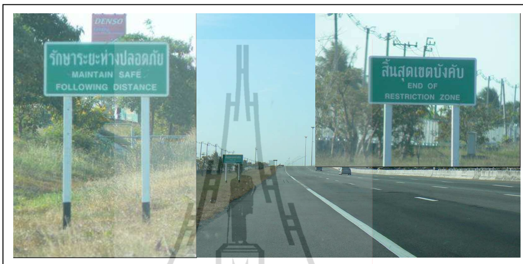
รูปที่ 3.38 การติดตั้งป้ายเตือนบริเวณก่อนและจุดสิ้นสุดเขตบังคับรักษาระยะห่าง
