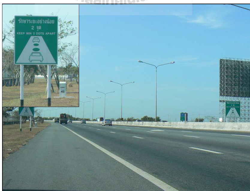
รูปที่ 3.37 การติดตั้งป้ายเตือนเป็นระยะเมื่อถึงบริเวณติดตั้งเครื่องหมายบนพื้นทาง
