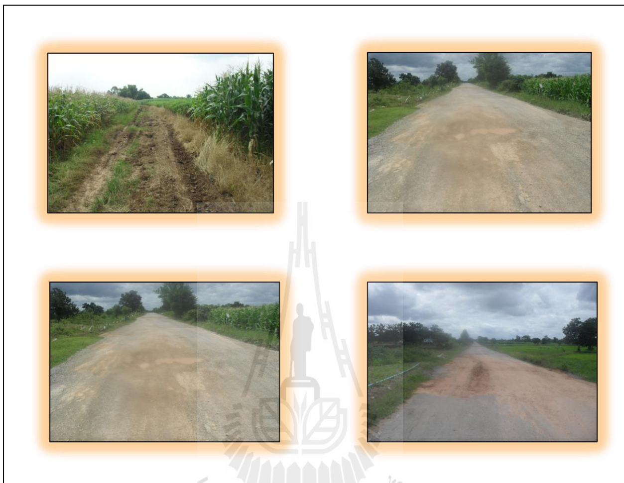
รูปที่ 1.4 สภาพถนนแต่ละประเภทที่ประชาชนใช้เดินทาง
