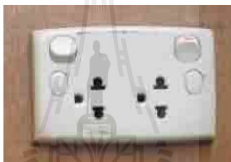
รูปที่ 9 ปลั๊กไฟ มีสวิตช์ตัดไฟ (ผศ. ไตรรัตน์ จารุทัศน์ และคณะ) พ.ศ.2548
