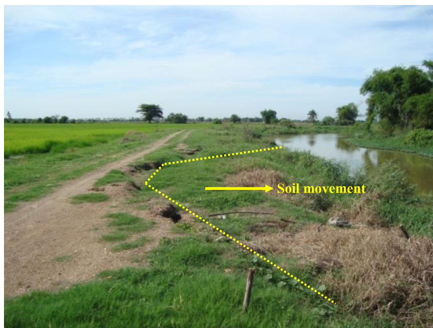
รูปที่ 4.1 การวิบัติของคันดินถมบนดินอ่อนริยบตลิ่ง
