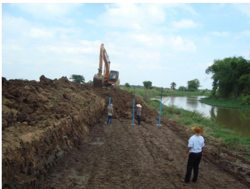
รูปที่ 4.5 การติดตั้งแผ่นทรุดตัวในแปลงทดลองที่ 2
