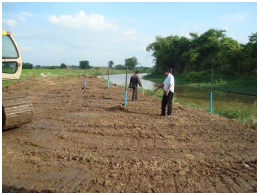
รูปที่ 4.9 การปรับแต่งผิวหน้าคันทางในแปลงทดลอง
