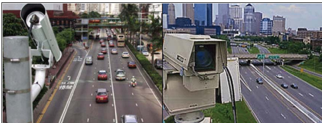
รูปที่ 2.2 ลักษณะการติดตั้งกล้องประมวลผลภาพในการใช้งาน
