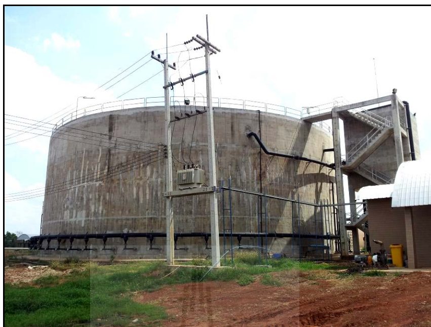
รูปที่ 4.31 ระบบบำบัดแบบไม่ใช้ออกซิเจน (UASB) ของโรงงาน
