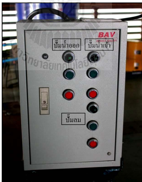
รูปที่ 4.13 ชุดควบคุมการทำงานของเครื่องปั้มน้ำและเครื่องปั้มนลม
