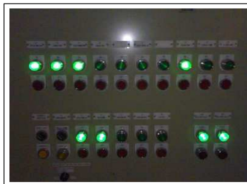
ฉ. เปิดสวิตช์ควบคุมการเดินระบบแก๊สซีไฟเออร์
