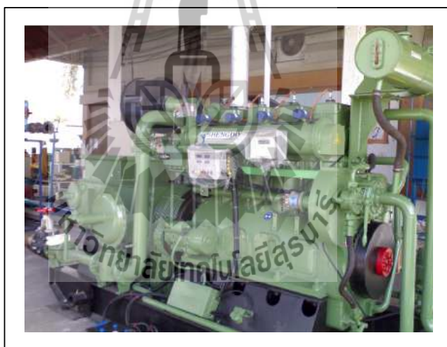
รูปที่ 3.11 เครื่องกำเนิดไฟฟ้าแบบซิงโครนัส
