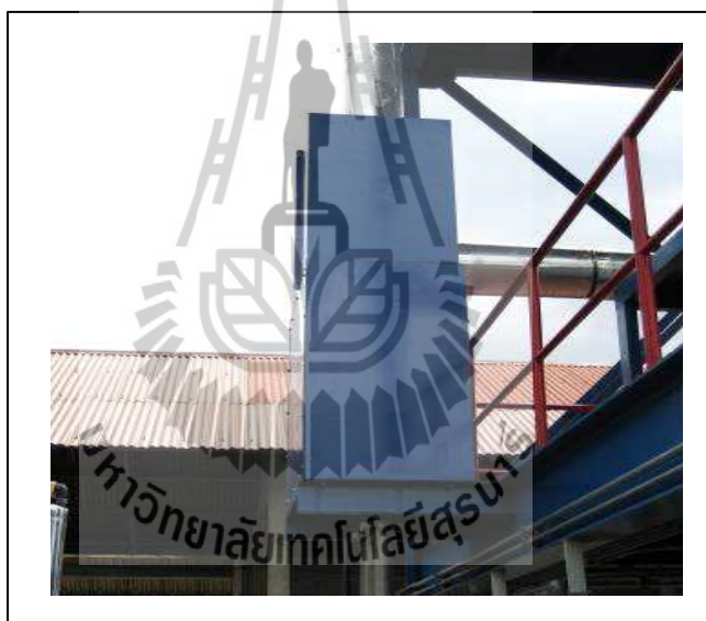
รูปที่ 3.3 Cyclone Collector
