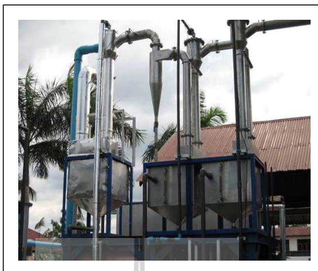
รูปที่ 3.4 Water Scrubber และ Chiller Scrubber
