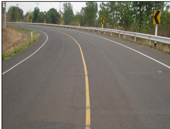
รูปที่ 3.8 หลังดำเนินการก่อสร้าง บริเวณทางโค้ง PI STA. 7+858.250
