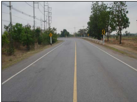
รูปที่ 3.5 หลังดำเนินการก่อสร้าง บริเวณทางโค้ง PI STA. 5+288.850
