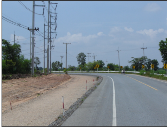
รูปที่ 3.7 ขณะดำเนินการก่อสร้าง บริเวณทางโค้ง PI STA. 7+858.250
