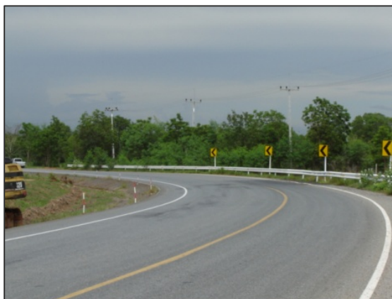
รูปที่ 3.6 ก่อนดำเนินการก่อสร้าง บริเวณทางโค้ง PI STA. 7+858.250
