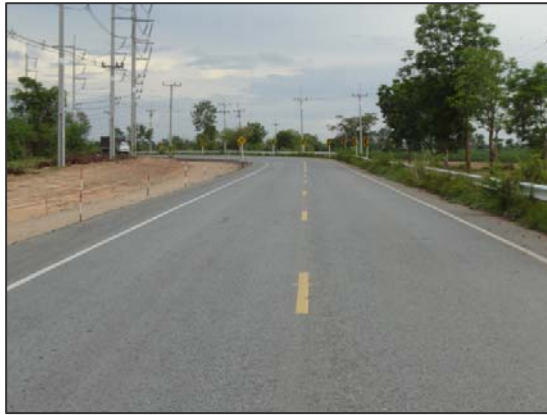
รูปที่ 3.4 ขณะดำเนินการก่อสร้าง บริเวณทางโค้ง PI STA. 5+288.850
