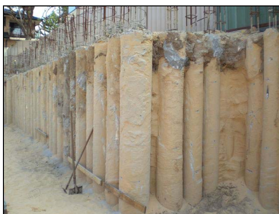
รูปที่ 2.7 ลักษณะของดินที่ไหลออกตามซอกเข็ม
