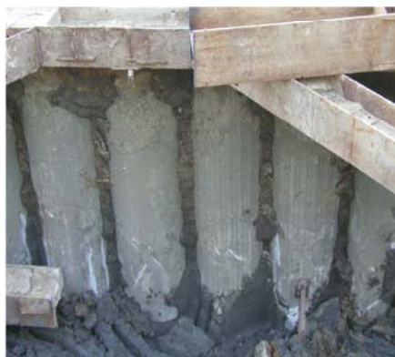
ภาพที่ 1 กำแพง CP wall ที่ใช้ในการก่อสร้างชั้นใต้ดินในดินเหนียวอ่อนกรุงเทพ
