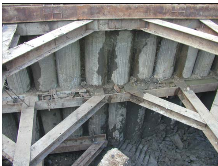
รูปที่ 2.2 งานขุดดินโดยใช้ระบบกำแพงกันดินแบบเสาเข็มเจาะเรียงต่อเนื่อง
