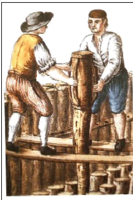
รูปที่ 2.3 การใช้กำแพงเสาเข็มไม้เรียงต่อเนื่องในอดีต (wikimedia. เว็บไซต์)
