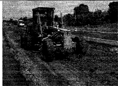
คลุกดินกับน้ำให้เข้ากัน
