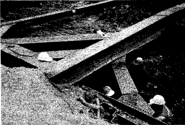
รูปที่ 6.23 การติดตั้ง Strut เข้ากับ Wale ยึดต่อกับด้วย Angle Reinforcement 60°
