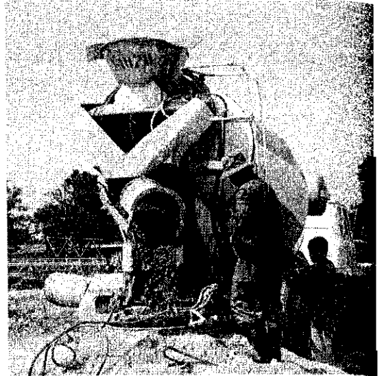
รูปที่ 3.8 การเทคอนกรีตในหลุมเจาะ
