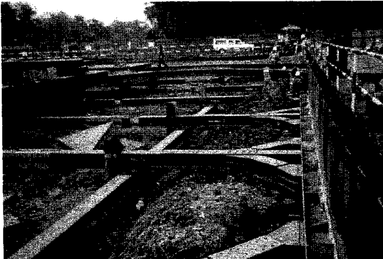
รูปที่ 6.24 แนว Strut ที่ติดตั้งเสร็จแล้ว
