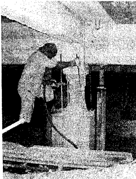
รูปที่ 3.22 การใช้ส่วนกะเทาะเสาต่อม่อ
