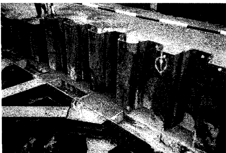
รูปที่ 6.22 การเทคอนกรีตบริเวณช่องว่างระหว่าง Wale กับเสาเข็มพีคเหล็ก
