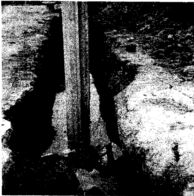
รูปที่ 6.16 การขุดหน้าดินและการจัดทำ Leg Guide
