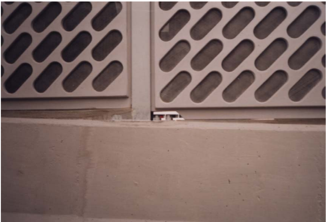
ภาพที่ 2.10 แสดงลักษณะแผ่นวัสดุดูดซับเสียงและลักษณะการติดตั้งที่ใช้ในปัจจุบัน
