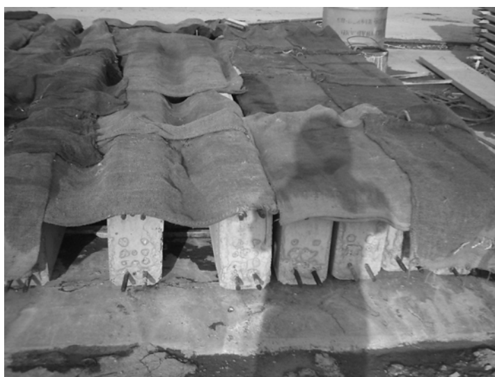
รูปที่ 3.16 การบ่มคอนกรีต
