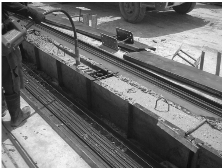
รูปที่ 3.15 การเทคอนกรีต
