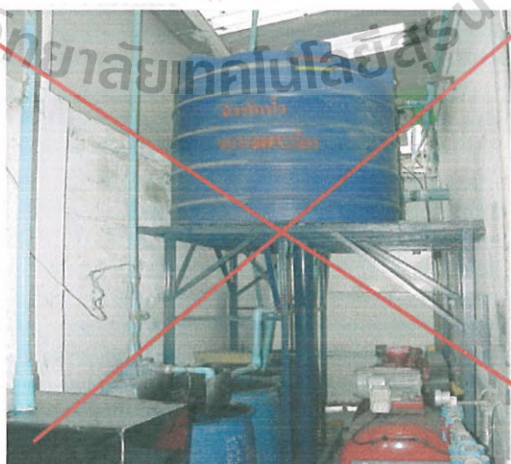
รูปที่ 13 : ถังพักน้ำเสียที่รื้อออกเพื่อลดขั้นตอนการบำบัด
