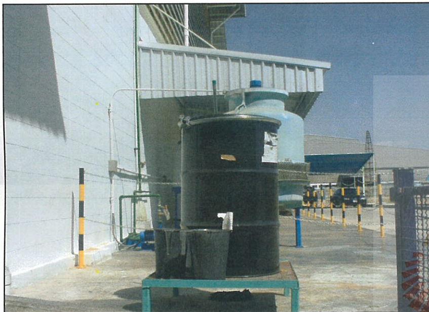
รูปที่ 3 : สถานที่ฉีดเก็บสารเคมี GRAPHITE SPRAY (วันที่ 1 พฤศจิกายน 2547)
