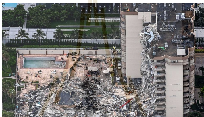
รูปที่ 1.1 สภาพหลังเกิดการถล่มลงของอาคารแชมเพลนทาวเวอร์สใต้ (Champlain Towers South ไมอามี-เดด เมืองเซิร์ฟไซด์ รัฐฟลอริดา ประเทศสหรัฐอเมริกา (The Visual Journalism Team, 2021)
