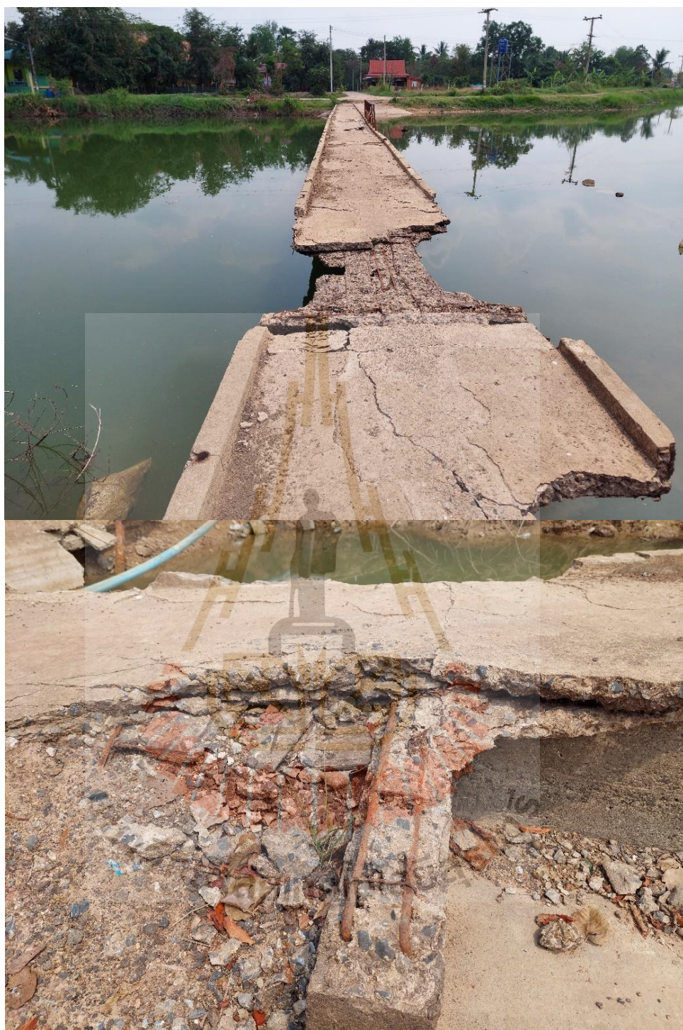
รูปที่ 1.7 ความเสียหายของพื้นสะพานที่เกิดจากการกัดกร่อนของน้ำบาดาลเค็ม ณ ฝายห้วยท่าแค - ห้วยก้องแก่ง บ้านสันเทียะ ต.โนนไทย อ.โนนไทย จ.นครราชสีมา (สำรวจ วันที่ 12 กุมภาพันธ์ พ.ศ. 2565), (กิตติเทพ เฟื่องขจร, พรวิสา วงศ์ปัญญา, เดโช เผือกภูมิ, และธนัชฐา ทองประภา, 2566)
