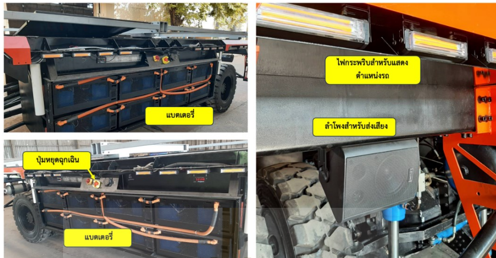
รูปที่ 3.8 แบตเตอรี่ ปั๊มหยุดฉุกเฉิน หลอดไฟ LED และลำโพงสำหรับส่งเสียงประกาศที่ติดตั้งอยู่กับตัวรถบรรทุกขับเคลื่อนอัตโนมัติ
