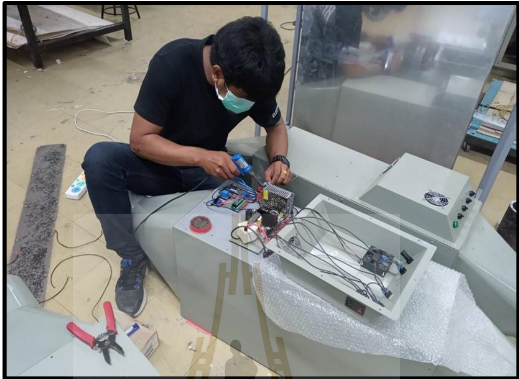
รูปที่ 3.14 การประกอบและติดตั้งส่วนของวงจรควบคุมและจ่ายกำลังงาน
