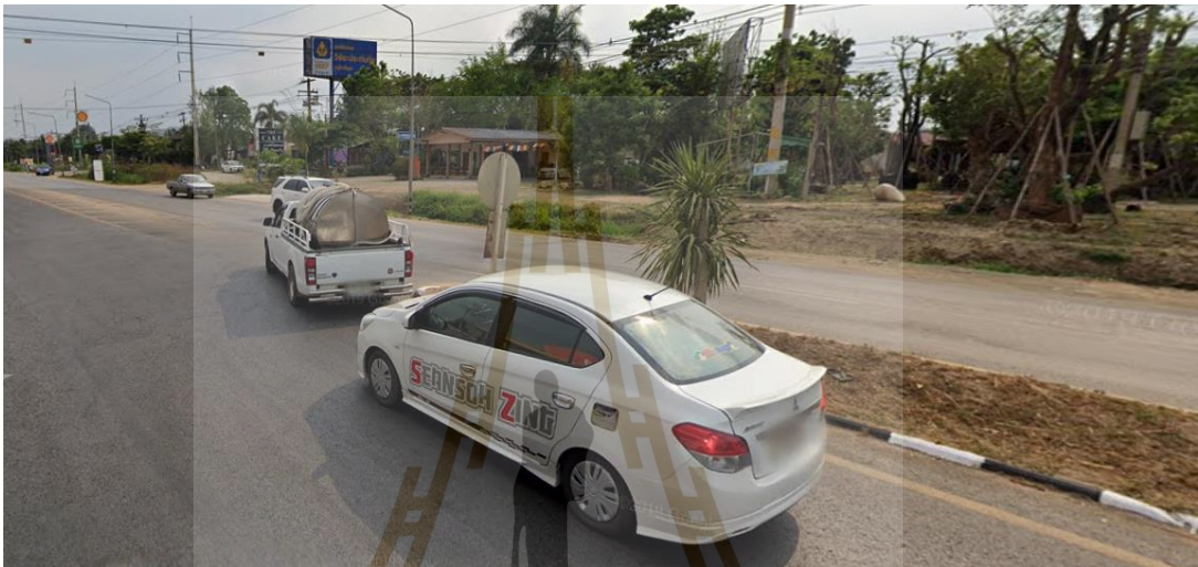
รูปที่ 4.8 แสดงลักษณะทางกายภาพบริเวณจุดกลับรถ บริเวณโรงงานเขาใหญ่เมทัลชีท ทล.2029
