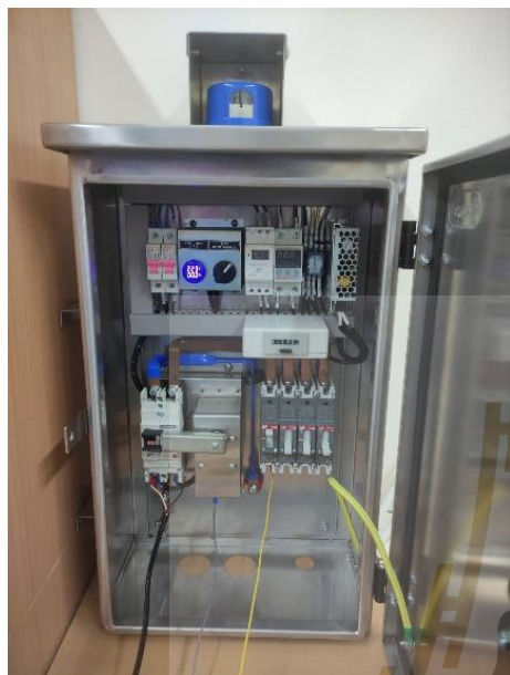
รูปที่ 3.21 เบรกเกอร์หลัก ON
