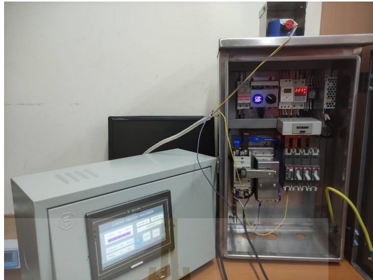
รูปที่ 3.19 เซอร์กิตเบรกเกอร์ ON
