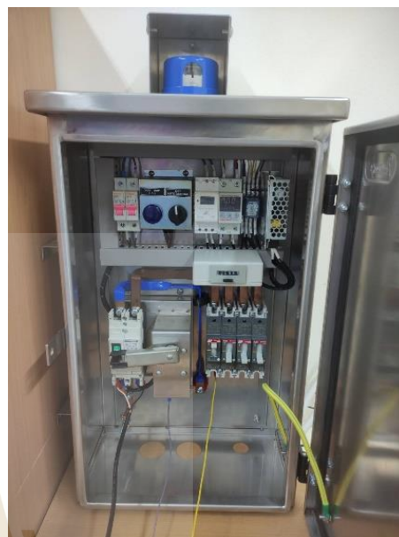
รูปที่ 3.22 เบรกเกอร์หลัก OFF
