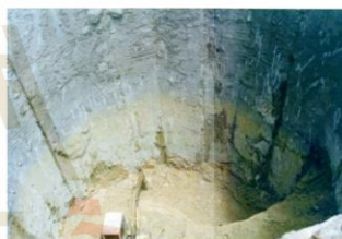
รูปที่ 1 การขุดเพื่อก่อสร้างปล่องที่ระดับความลึก 21 เมตร เมื่อปี ค.ศ. 1997 ดินกันบ่อแห้งไม่มีน้ำใต้ดินเข้ามาในบ่อ
