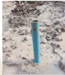
1. กดท่อ PVC ลงในดิน บรรจุน้ำปูนแล้วเทออกจากนั้นถอดท่อ PVC ทิ้งเพื่อให้น้ำปูนบรรจุในหลุม
