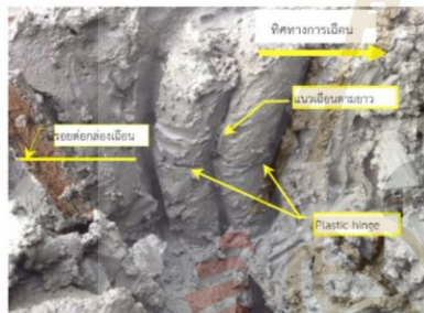
รูปที่ 6 รูปแบบการวิบัติของ SCC ที่เว้นช่วงเวลา 24 ชั่วโมง เป็นแบบ shear failure along column [5]
