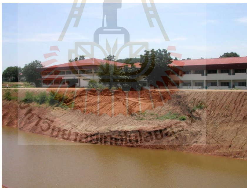
รูปที่ 2.5 การวิบัติลาดดินอ่างเก็บน้ำเนื่องจากชั้นดินเหนียวบวมตัวแทรกแบบเอียงตัวอยู่ในชั้นดินเหนียวแข็ง (พรพจน์ และพลอนันต์, 2552)
