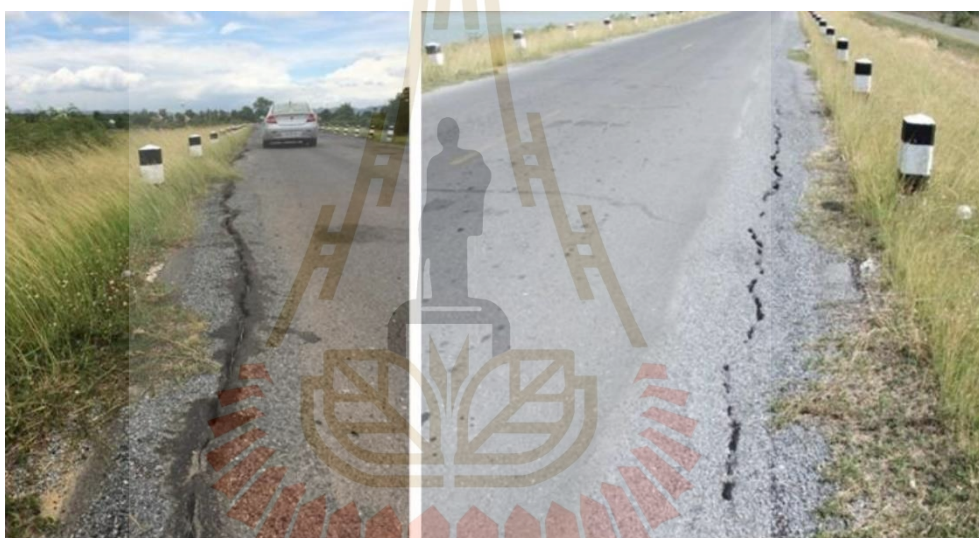
รูปที่ 2.19 รอยแตกตามยาวพบบนสันเขื่อนทั้งด้านเหนือน้ำและท้ายน้ำ (กรมชลประทาน, 2556)
