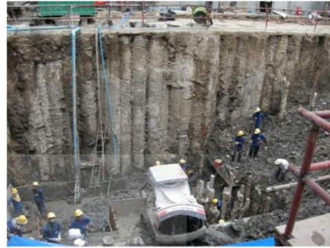
รูปที่ 9 ภาพถ่ายขณะขุดดินที่ระดับความลึกสูงสุด 7.4 เมตร
