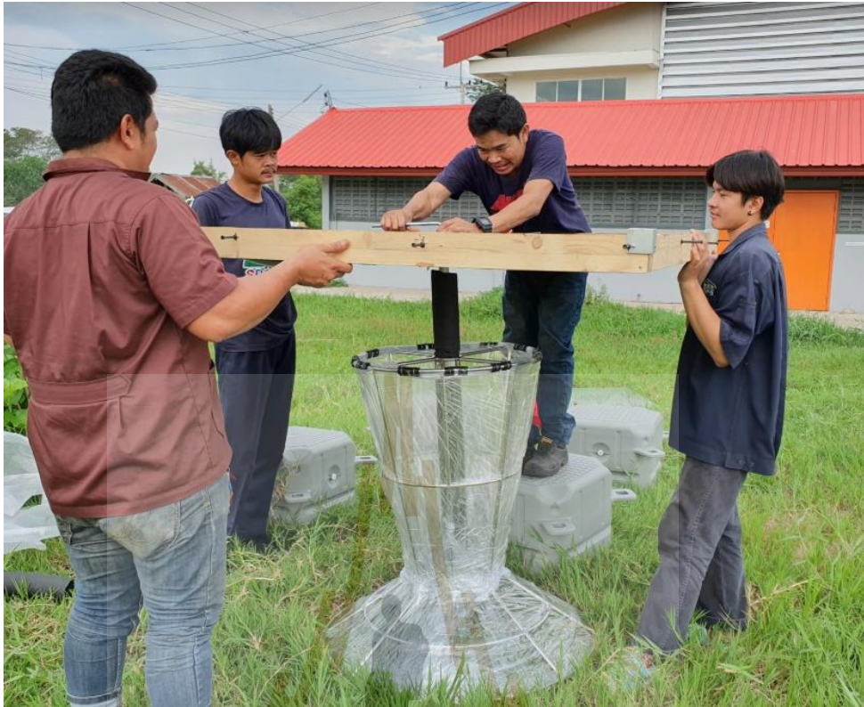
รูปที่ ก.7 ระบบ SCWAS หลังประกอบเข้าด้วยกัน
