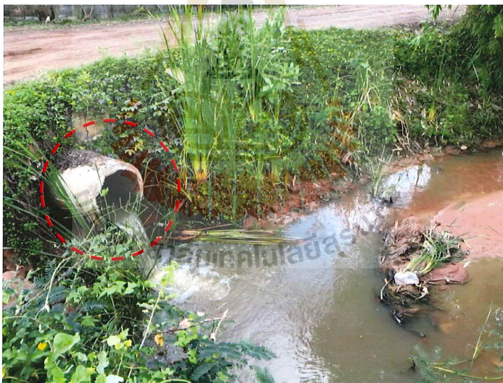
รูปที่ 4.15 ลักษณะการระบายรูปแบบที่ 1 (ใช้ท่อระบายน้ำสาธารณะและระบายลงสู่จุดรับน้ำเสีย)
