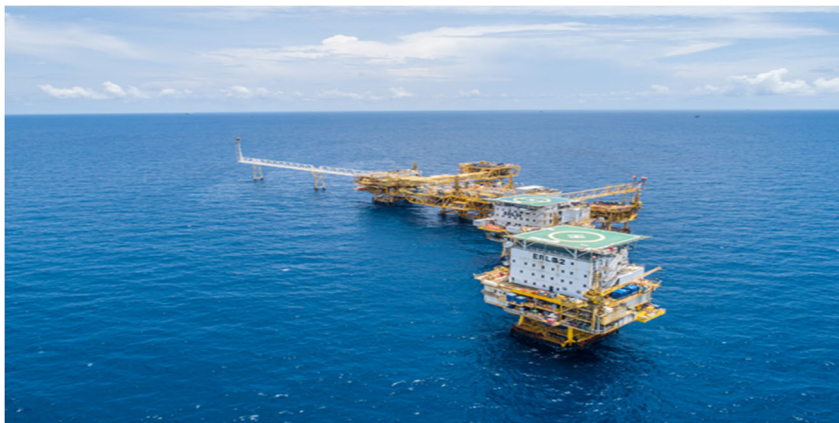
ภาพที่ 2.2 ลานจอดเฮลิคอปเตอร์บนแท่นขุดเจาะน้ำมัน
