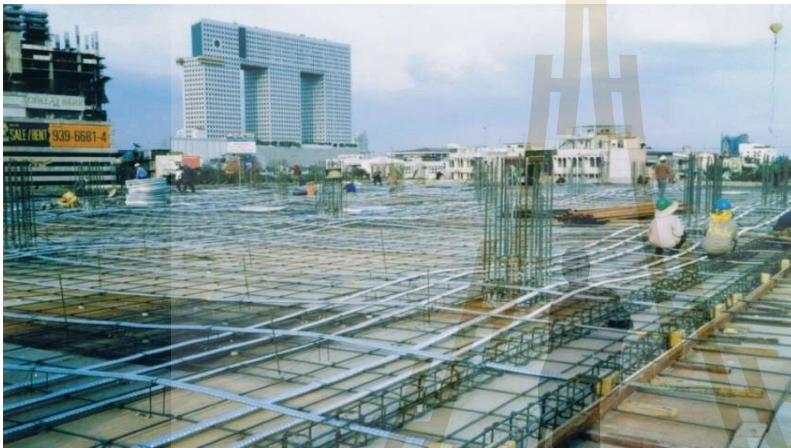
รูปที่ 1.1 พื้นคอนกรีตอัดแรง ชนิดมีแรงยึดเหนี่ยว (Bonded Post-tensioned Slab) ไร้คานรองรับ ที่นิยมแพร่หลายในประเทศไทย
