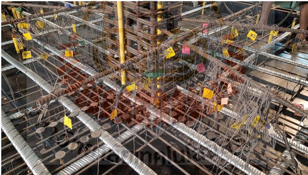
รูปที่ 3.10 ภาพถ่ายแสดงจุดเชื่อมต่อแบบจำลอง SS2 ที่ติดตั้งสายสัญญาณแล้วก่อนการเทคอนกรีต
