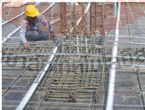
รูปที่ 2.20 การเสริมเหล็กกับแรงเฉือนชนิดเหล็กปลอกปิดที่นิยมใช้งานในประเทศไทย
