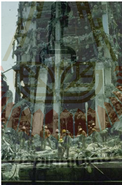
รูปที่ 1.3 ตัวอย่างการวิบัติแบบเฉือนทะลุ และทำให้เกิดการวิบัติแบบก้าวหน้าของอาคารทั้งหลัง ในระหว่างเหตุการณ์แผ่นดินไหว the September 1985 Mexico City earthquake (After Mitchell et al. 1986)
