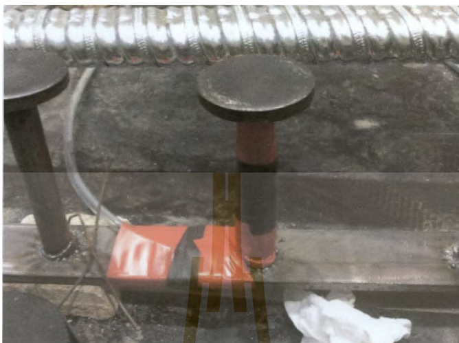
รูปที่ 2.16 ภาพขยายหมุดรับแรงเฉือนที่ใช้ในการติดตั้งจริงโดย กฤษฎา โพธิ์สัย (แหล่งที่มา กฤษฎา โพธิ์สัย 2017)
