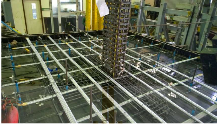
รูปที่ 2.22 ภาพแบบจำลองที่มีการเสริมเหล็กปิดกั้นในแบบจำลอง SS1 ก่อนการเทคอนกรีต (แหล่งที่มา Prawatwong et al., 2020)
