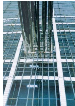
รูปที่ 1.1 พื้นคอนกรีตอัดแรง ชนิดมีแรงยึดเหนี่ยว (Bonded Post-tensioned Slab) ไร้คานรองรับ ที่นิยมแพร่หลายในประเทศไทย
