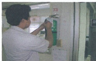
รูปที่ ข-1 ภาพการตรวจสอบถังดับเพลิง
