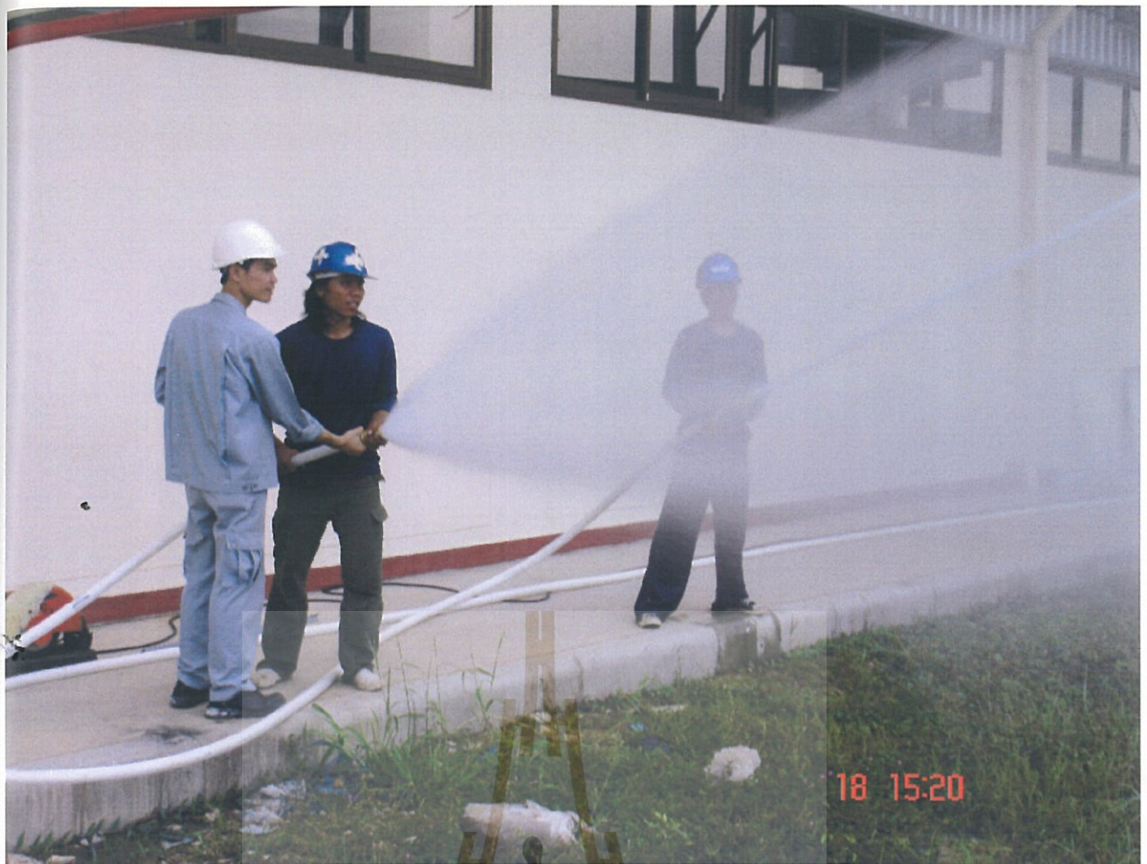
ภาพการทดสอบสายดับเพลิง (FIRE PUMP)
