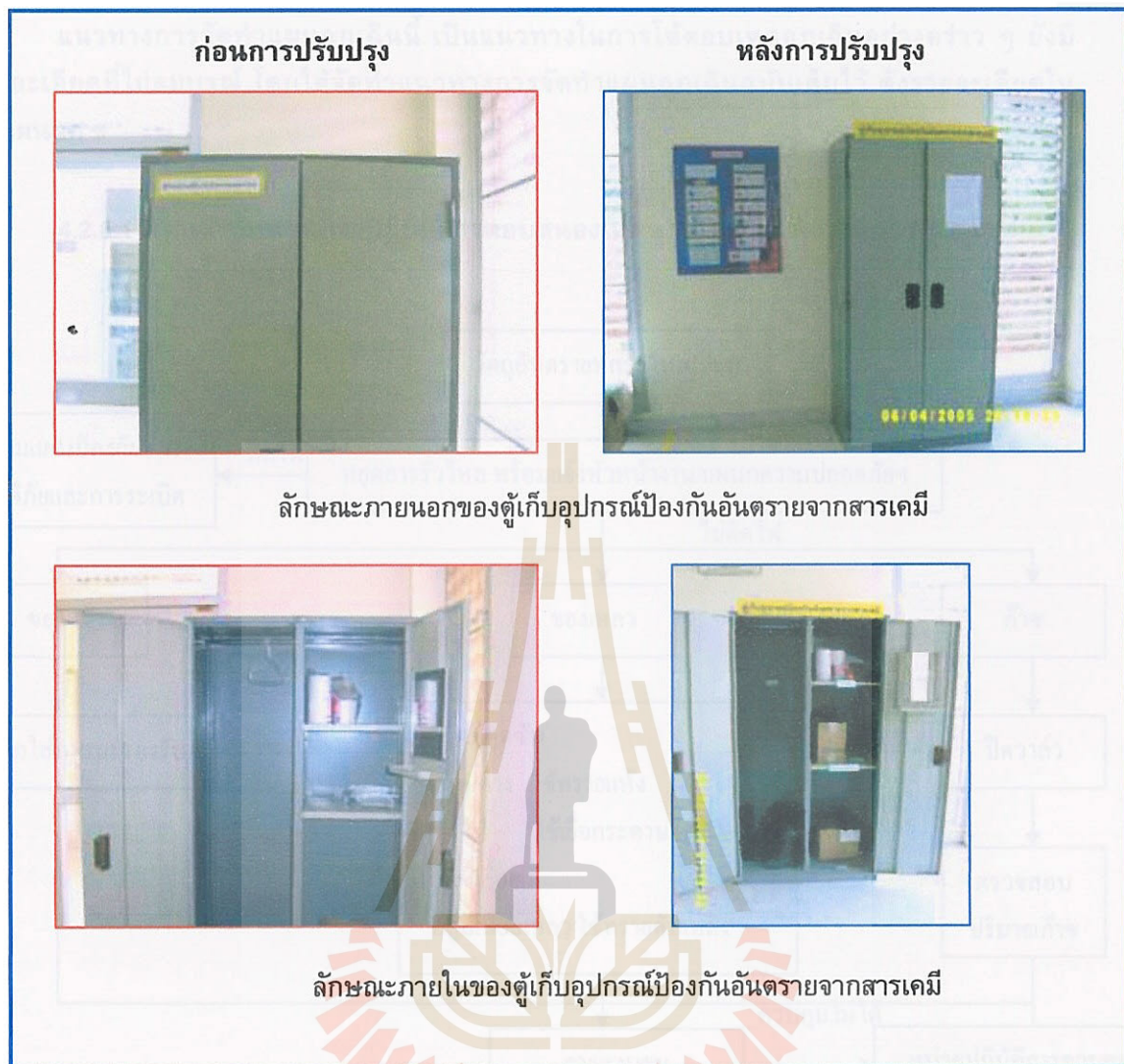
ภาพที่ 4.7 ลักษณะตู้เก็บอุปกรณ์ป้องกันอันตรายส่วนบุคคลก่อนและหลังการปรับปรุง
