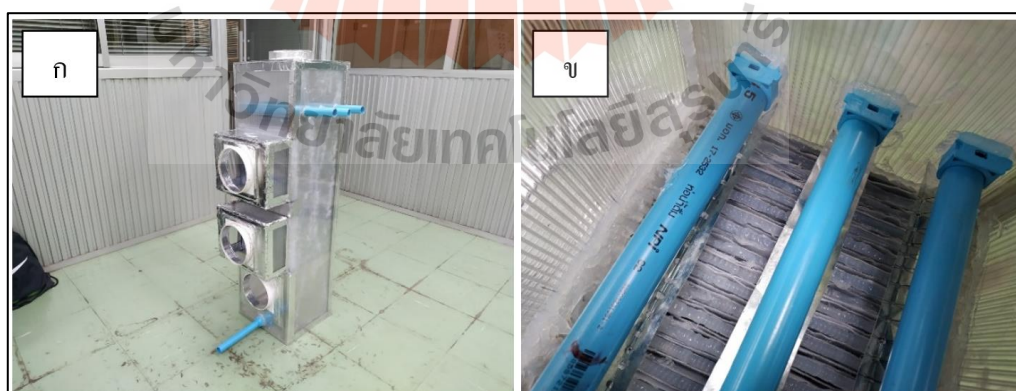
รูปที่ 3.24 ระบบน้ำหลังติดตั้งบนแกนทำความเย็น (ก) ระบบท่อจ่ายน้ำ (ข) ระบบรางน้ำ
