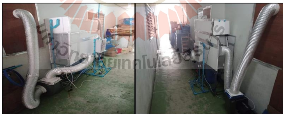
รูปที่ 3.41 เครื่องทำความเย็นแบบน้ำระเหยชนิดไหลตั้งฉากหลังติดตั้งท่อลมและระบบไฟฟ้า
