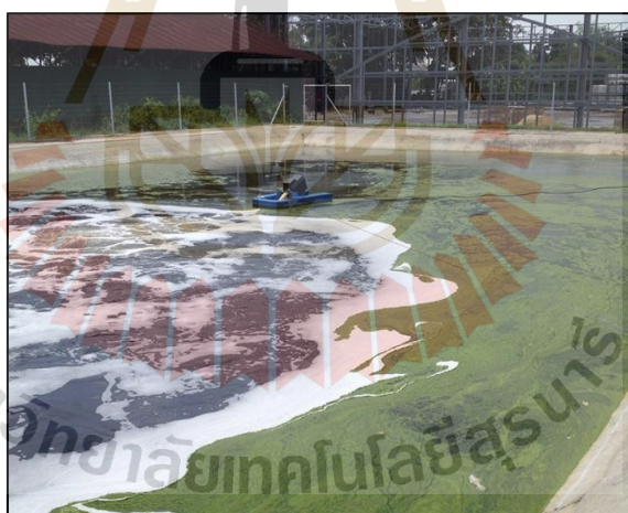
ข. บ่อสารละลายของเสียในอุตสาหกรรมซุบเคลือบผิวโลหะ
