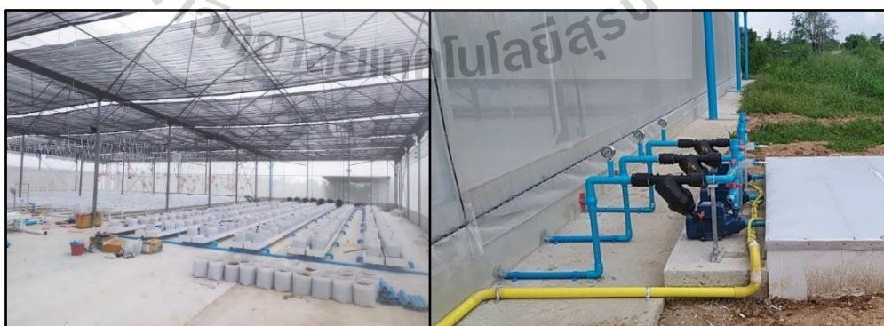
รูปที่ 4.27 ติดตั้งระบบพ่นหมอก สแลนพรางแสง และพัดลมระบายอากาศภายในโรงเรือน
