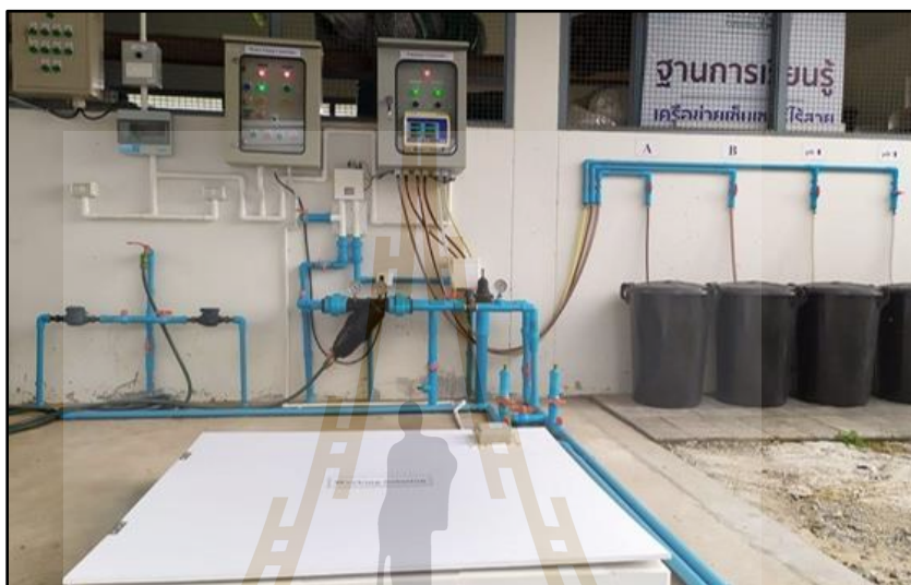
รูปที่ 4.6 ระบบควบคุมการให้ปุ๋ยอัตโนมัติ
