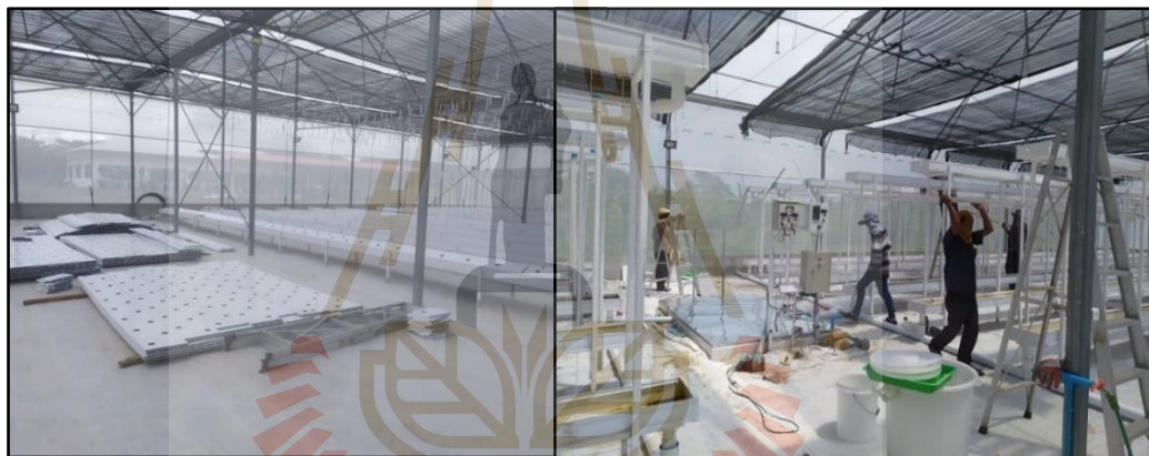
รูปที่ 4.30 การติดตั้งรางปลูกพืชแบบไม่ใช้ดิน
