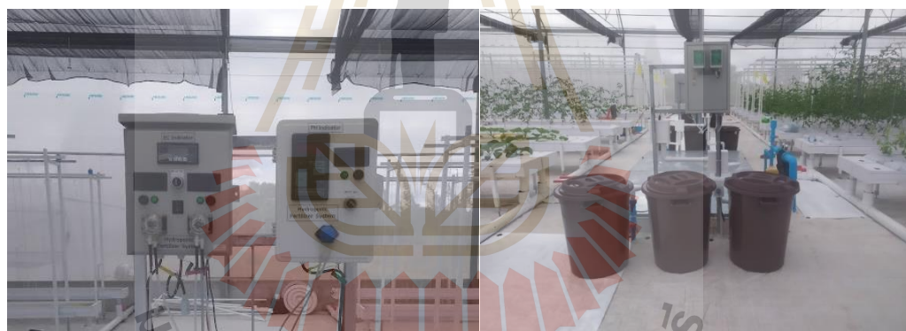
รูปที่ 4.34 ติดตั้งระบบน้ำ ปั๊มน้ำ Timer ตั้งเวลาให้น้ำ และระบบผสมปุ๋ยอัตโนมัติ สำหรับระบบน้ำหยด
