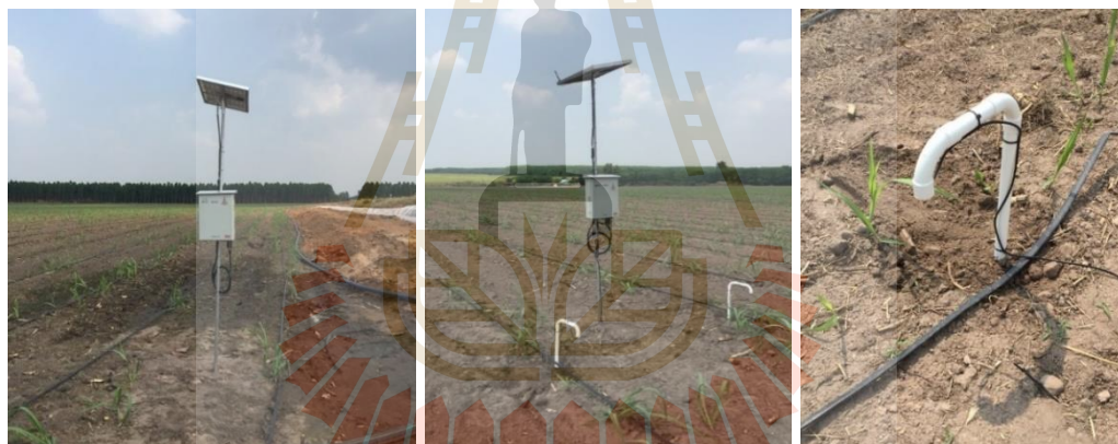
รูปที่ 3.11 การติดตั้ง A) โหนดโคออร์ดิเนเตอร์ B) โหนดเราท์เตอร์ C) sensor EC5
