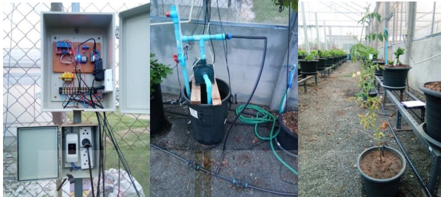
รูปที่ 4.45 การติดตั้งกล่องควบคุมระบบปั้มน้ำและโซลินอยด์วาล์ว และระบบน้ำหยดและหัวน้ำหยด
