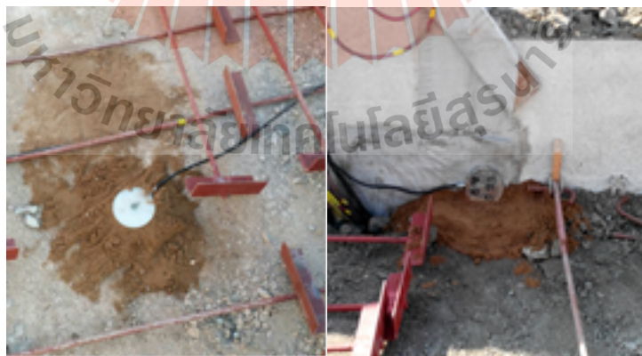
รูปที่ 3.5 แสดงการติดตั้ง Earth Pressure
